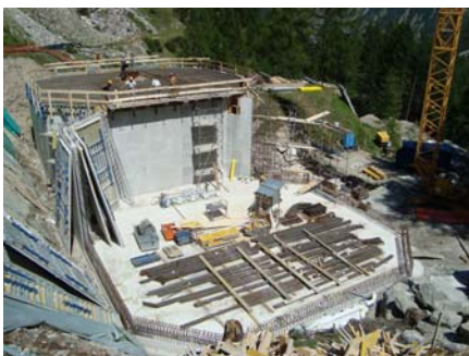
Sicht auf die beiden Reservoirbehälter während der Bauarbeiten
