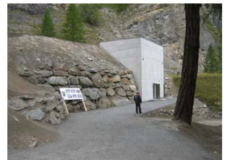
Das sichtbare Schieberhaus nach der Inbetriebnahme
