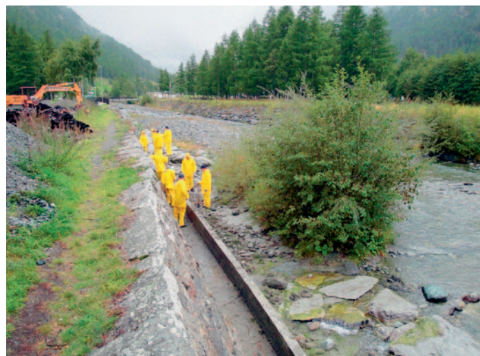
Ausputzen Wasserfassung Gstein
