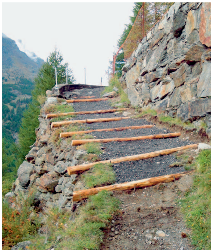
Sanierung Wanderweg Annakapelle
