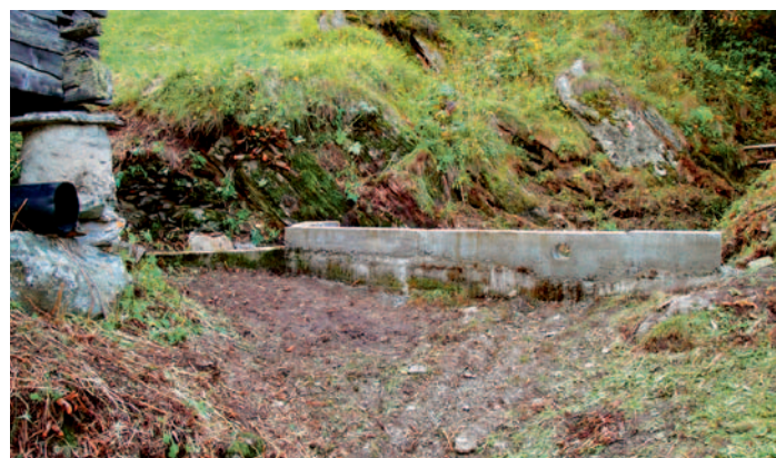
Aufbau und Sanierung Wasserfassung Unter den Bodmen
