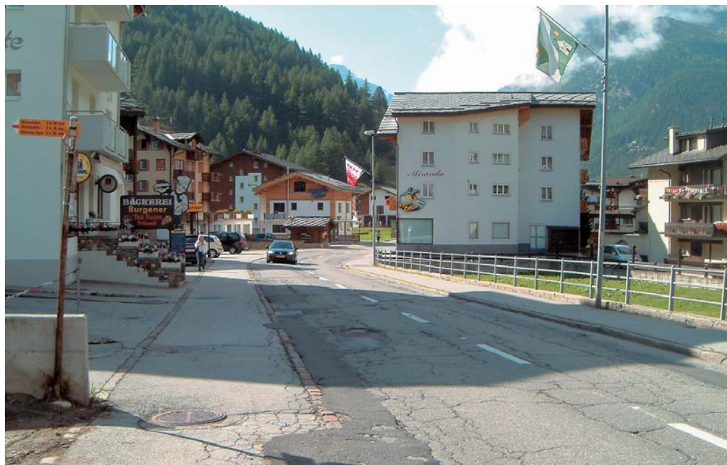
Risse im Belag, die Hauptstrasse in Saas-Grund ist sanierungsbedürftig. Nun werden rund 1,1 Kilometer saniert, wovon das Teilstück von der Triftbachbrücke bis zum Haus Miranda komplett neu erstellt wird.
