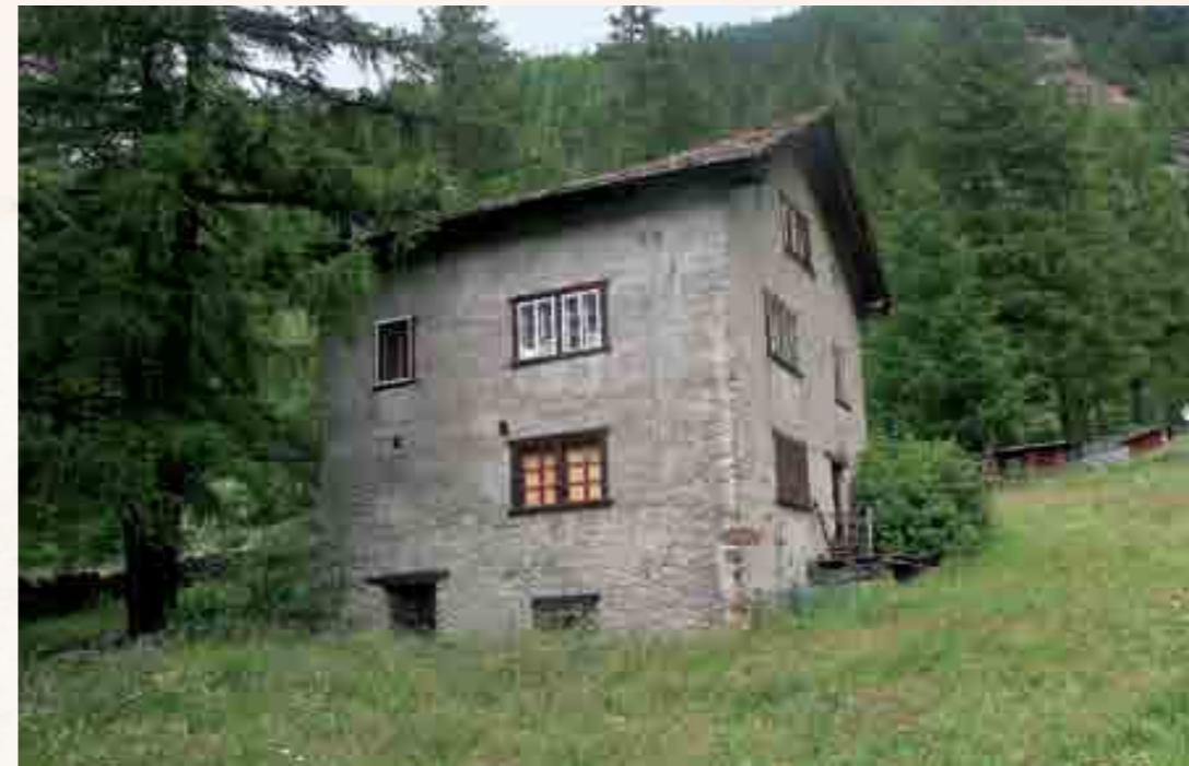
Sieht unscheinbar aus, verbirgt aber Schätze in seinem Innern: Das schützenswerte Gebäude mit wassergetriebener Mühle, Walke und Säge befindet sich im Weiler Unter dem Berg am Triftbach in Saas-Grund.
