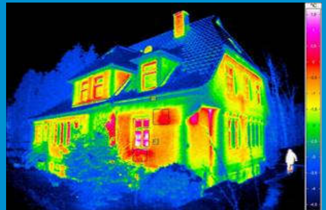
Wärmebildaufnahme eines Gebäudes
