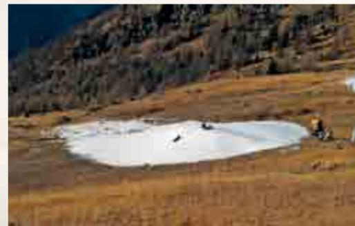
Eine Skipiste entsteht: Zuerst werden verschiedene Schneehügel produziert. Diese bleiben mindestens drei Tage an Ort und Stelle liegen, damit die Masse durchfrieren kann und so genannt trockener Schnee gebildet wird. Erst dann werden die Hügel mit Pistenfahrzeugen verstossen. Bis zu 75 Prozent der Pisten können beschneit werden.
