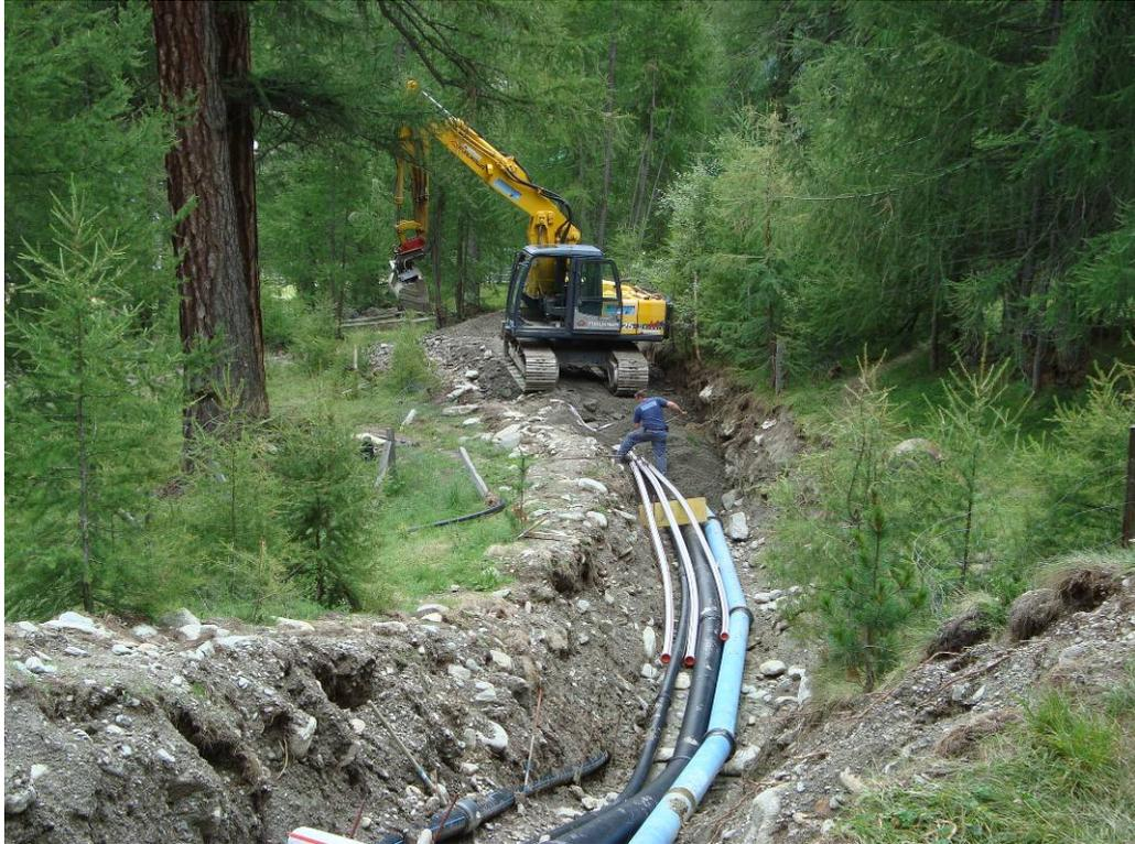
Die neue Ableitung durch den Lärchenwald entsteht. Im gleichen Graben werden Kabelschutzrohre, Abwasser und Sauberwasserrohre verlegt. (Foto: Michael Steiner, 18.8.2010)
