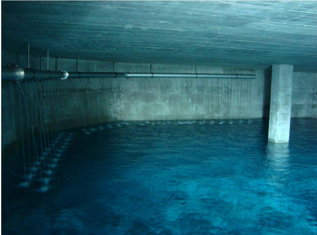
Blick in den rechten Behälter des neuen Reservoirs bei der Inbetriebnahme der Turbine. Das zufließende Wasser aus den kleinen Öffnungen kommt von den Quellen Schlafbrunnen und wurde zuvor turbiniert. (Foto: Michael Steiner, 9.9.2010)
