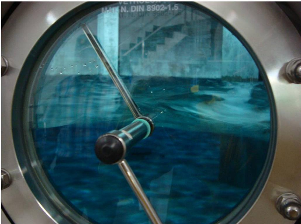
Blick in einen der beiden Behälter durch das Guckloch in der Unterwassertüre. Der Behälter wird gerade gefüllt, nachdem er von einer Spezialfirma desinfiziert wurde. Wenige Tage später wird das neue Reservoir angeschlossen. (Foto: Michael Steiner, 1.9.2010)
