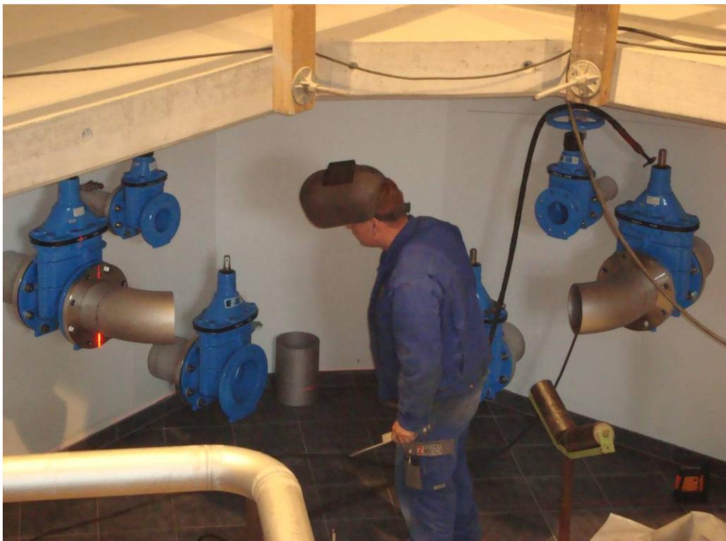
Montage der Armaturen und Schweißen der Rohrleitungen in rostfreiem Stahl im Schieberhaus des neuen Reservoirs. (Foto: Michael Steiner, 8.6.2010)
