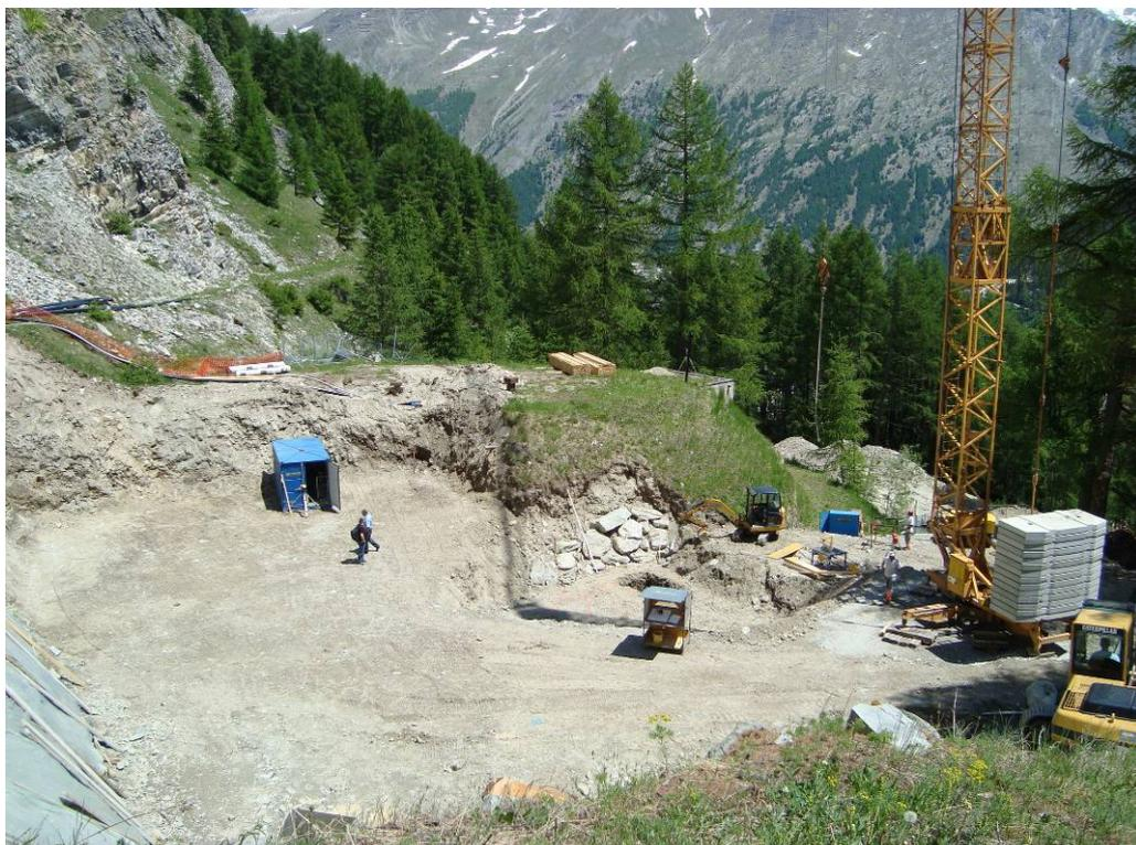
Der Aushub des neuen Reservoirs ist beendet. Das alte Reservoir aus dem Jahr 1928 ist bereits abgebrochen. Der kleine Hügel in der Mitte des Bildes ist das zweite alte Reservoir, welches während den Bauarbeiten die Gemeinde mit Trinkwasser versorgte. (Foto: Michael Steiner, 17.6.2009)
