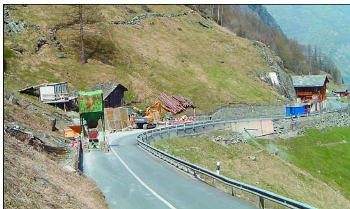
Aufnahmen der Baustelle «Zer Ramschflüo», wo Massnahmen zur Verbesserung der Fahrbahnbreite und Linienführung ausgeführt werden. Wie bergseitiger Felsabtrag (Foto links) und Erstellung einer neuen Futtermauer (Foto rechts).
