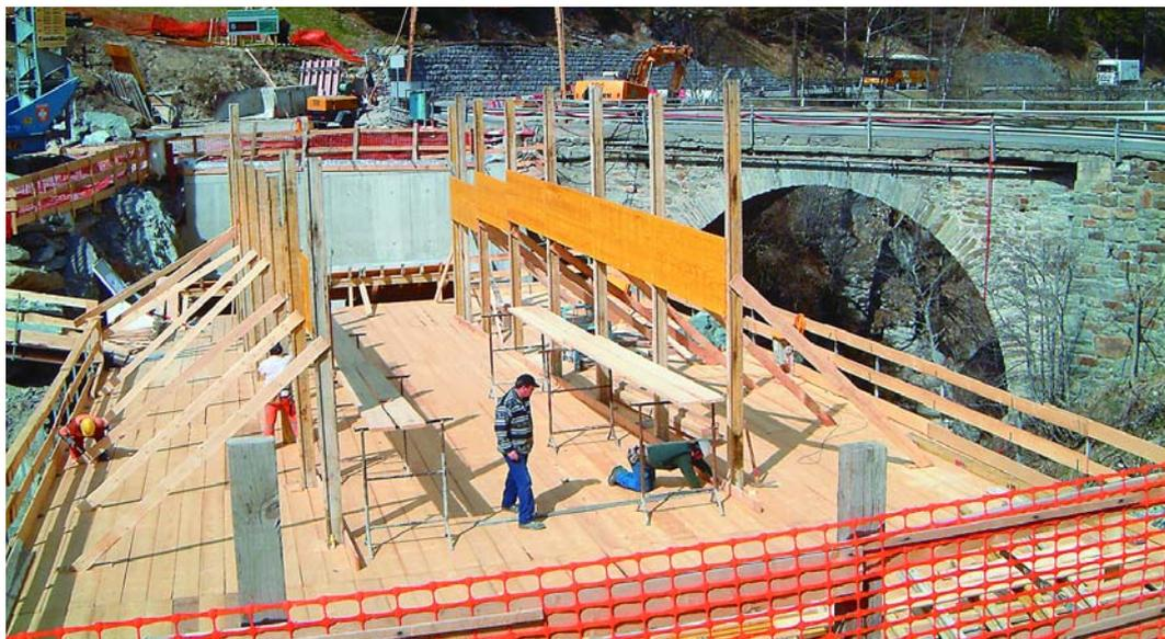
Bei der alten Bodenbrücke, die als Bauwerk von historischem Wert gilt und deshalb erhalten bleibt, entsteht eine neue, 36 Meter lange Betonbogenbrücke.
