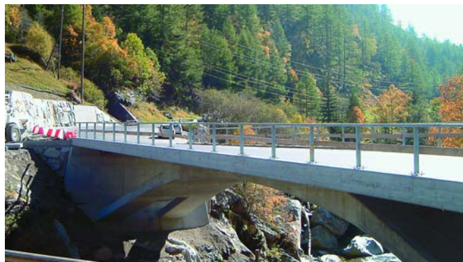
Weiler Ze Briggeltinu: Verbesserte Linienführung und Beseitigung des Engpasses dank der neuen, zweispurigen Betonbogenbrücke.
