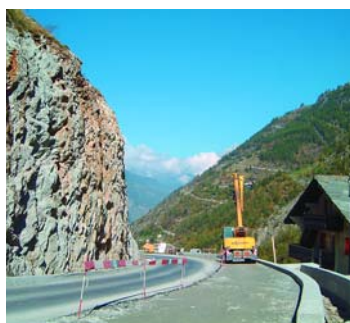
Im Gebiet Zer Ramschflüo wurde die Fahrbahn verbreitert und der Hang durch eine neue Futtermauer stabilisiert.
