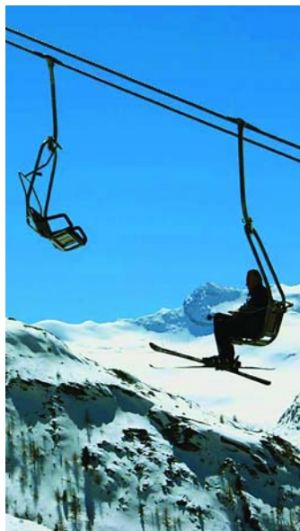
Die Saas-Almagell Bergbahnen AG investierten rund 874 000 Franken in die Erweiterung der Beschneigungsanlage.
