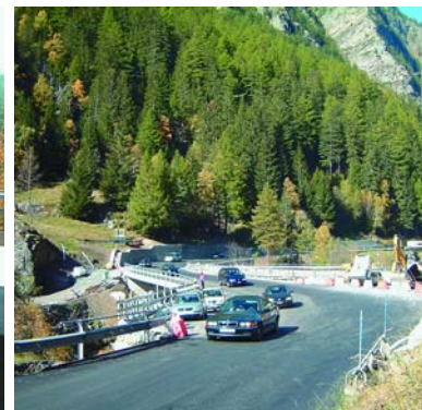
Weiler Ze Briggeltinu: Verbesserte Linienführung und Beseitigung des Engpasses dank der neuen, zweispurigen Betonbogenbrücke. (Aufnahmen vom 7. Oktober 2007)
