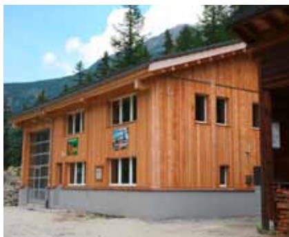
Werkhof Saastal: Der neue Werkhof des Saastals ist fertig. Die «Gletscher-Post» gewährt erste Einblicke.
